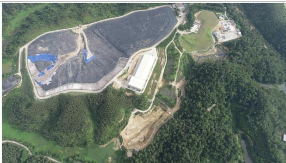
垃圾填埋场现场照片
