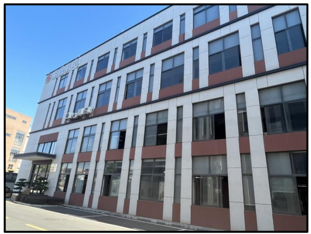
项目东面-江门期晟机电科技有限公司
