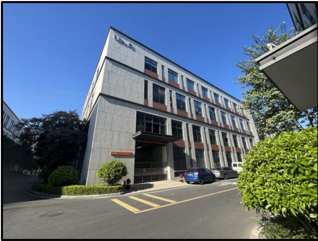
项目北面-广东明峰拉链科技有限公司
