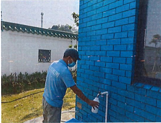
第三水厂出厂水采样口
