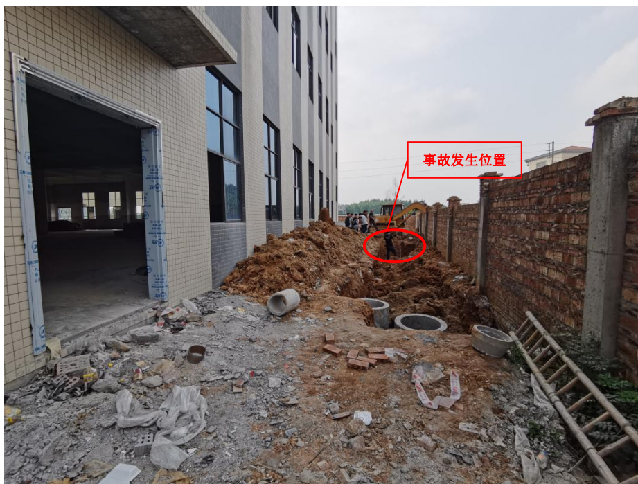
图 3 管道安装工程现场情况
