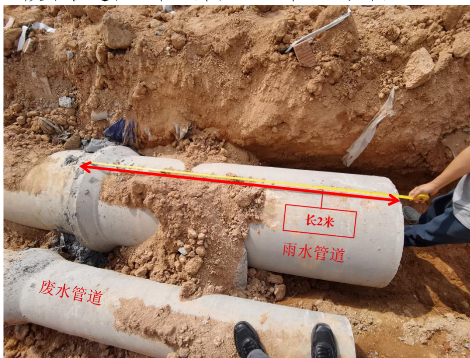
图4 雨水管道、废水管道
